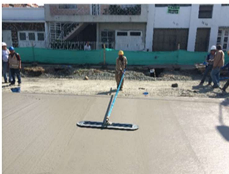
Flotado del Concreto
