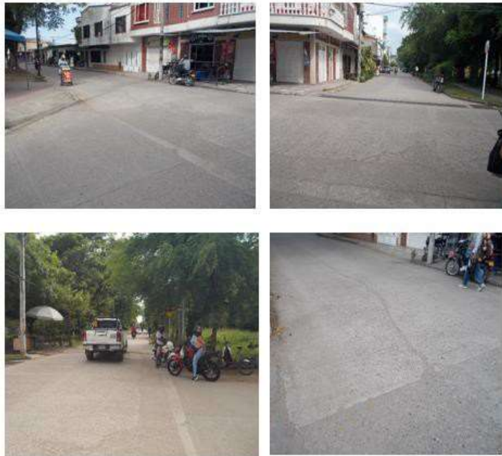
Registro fotográfico tramo: Calle 26 entre carreras 5 y 6. Fuente: Propia (2023)
