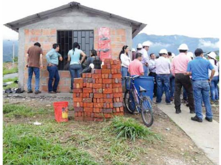
Ingenieros trabajan en construcción de viviendas.
