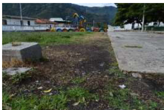
Estado actual de la Obra
