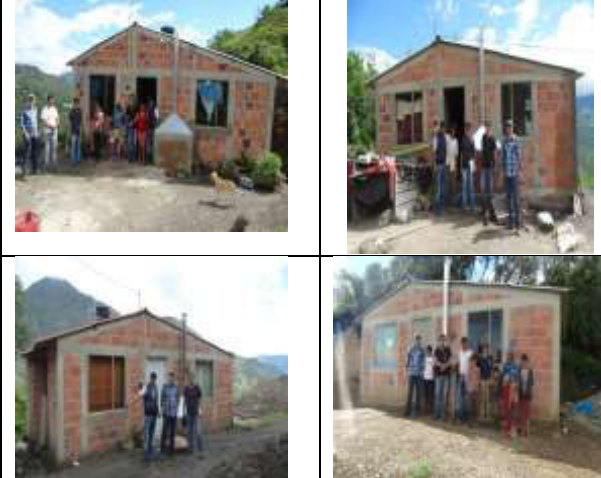
CONSTRUCCIÓN DE ALCOBAS
