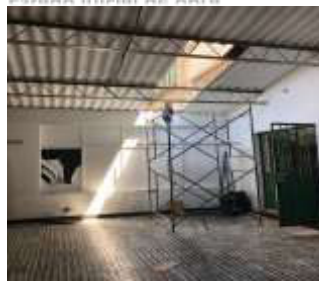
Estado inicial de obra
