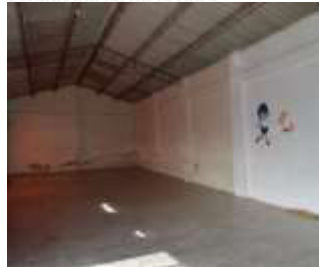
Estado inicial de la obra
