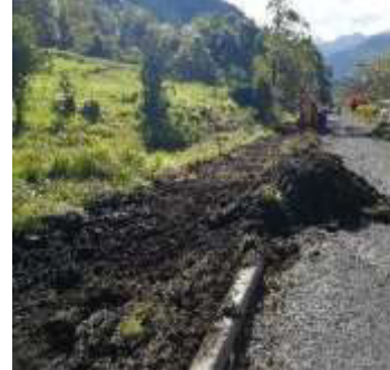
Estado inicial de Obra
