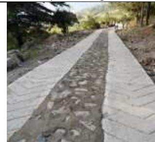
Estado en que se entregó la obra
