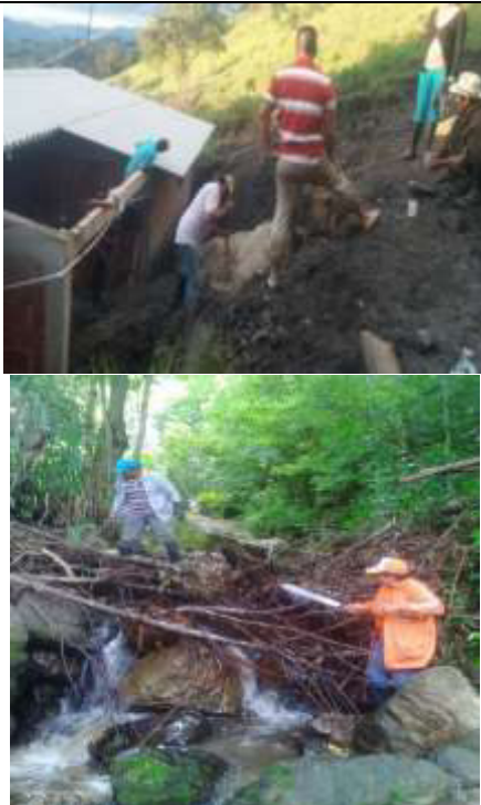
Afectación de viviendas ola invernal
