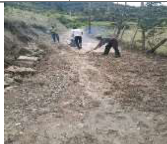
Estado en que se recibió la obra
