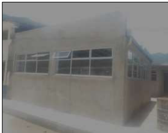
Estado inicial de la obra
