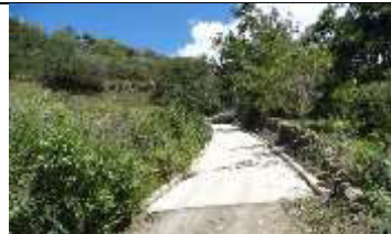
Estado en que se recibió la obra.
