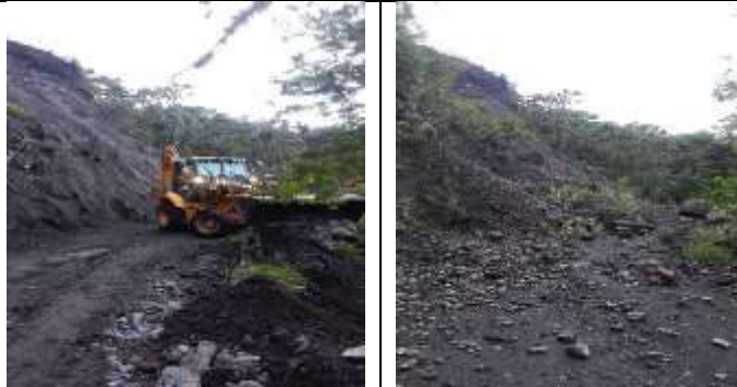
Remoción de derrumbes ola invernal
