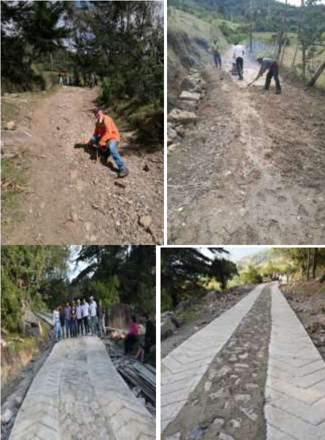
Estado en que se encontraba la obra
