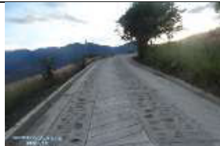
Estado en que se entregó la obra.
