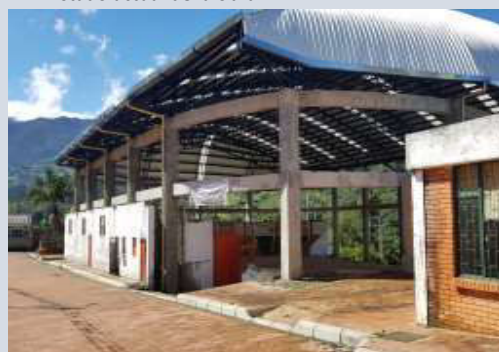
Estado actual de la obra
