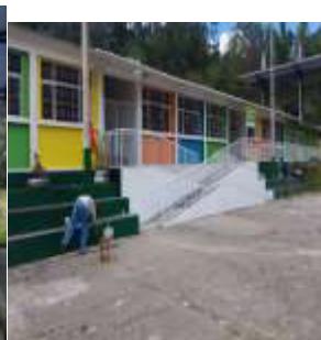
Estado final de la obra
