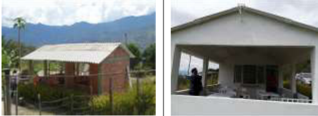
Inicio de obra
