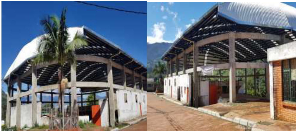
Estado en que se encuentra la obra
