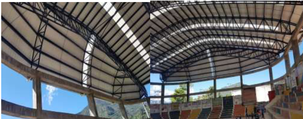
Adecuación cubierta Coliseo
