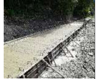
Estado actual de la obra
