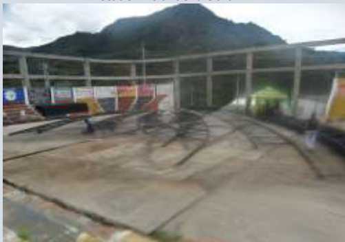
Estado inicial de la obra
