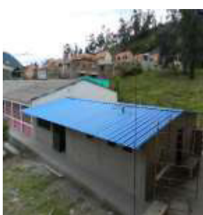
Estado inicial de la obra
