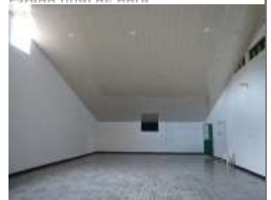
Estado final de obra
