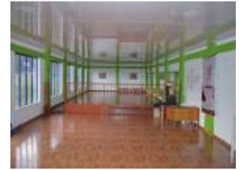
Estado final de la obra
