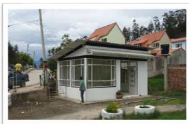
Estado final de la obra
