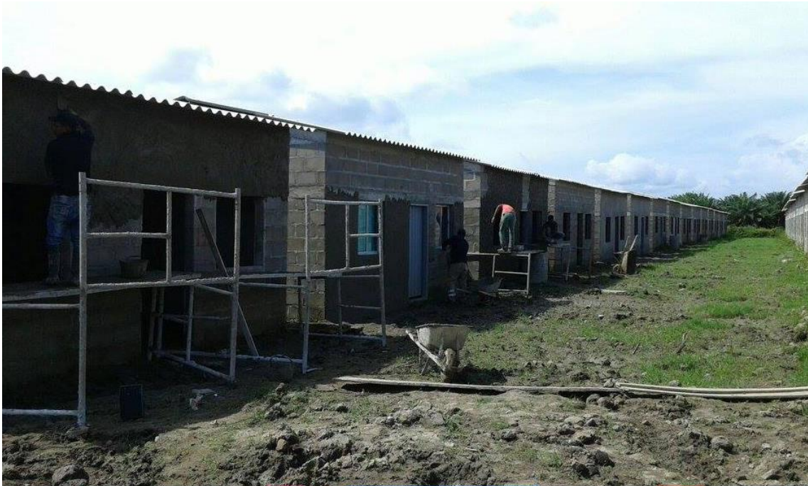
Proyecto de vivienda de interés social en ejecución Fuente: secretaria de planeación Municipal
