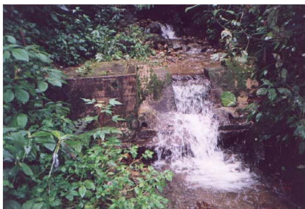
Detalle de la captación, acueducto de la vereda Caraqueño. Q. La Chivera. Foto tomada por REYES O.
