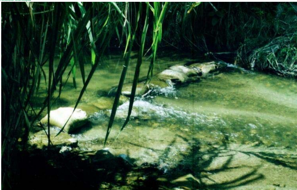
Río Güengüé y dique con costales de arena para derivación de agua para riego de caña. Vereda Tierradura
