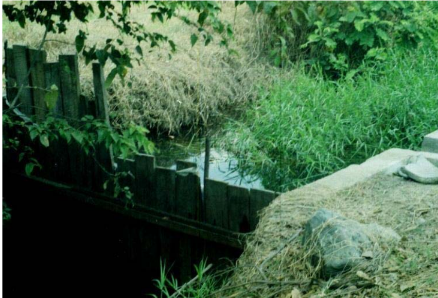
Trincho de madera para subderivar agua de acequia para riego de caña de azúcar.
