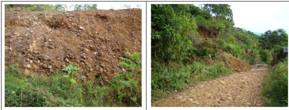
Taludes de las antiguas terrazas aluviales y los pequeños deslizamientos que afectan las vías a los barrios.
