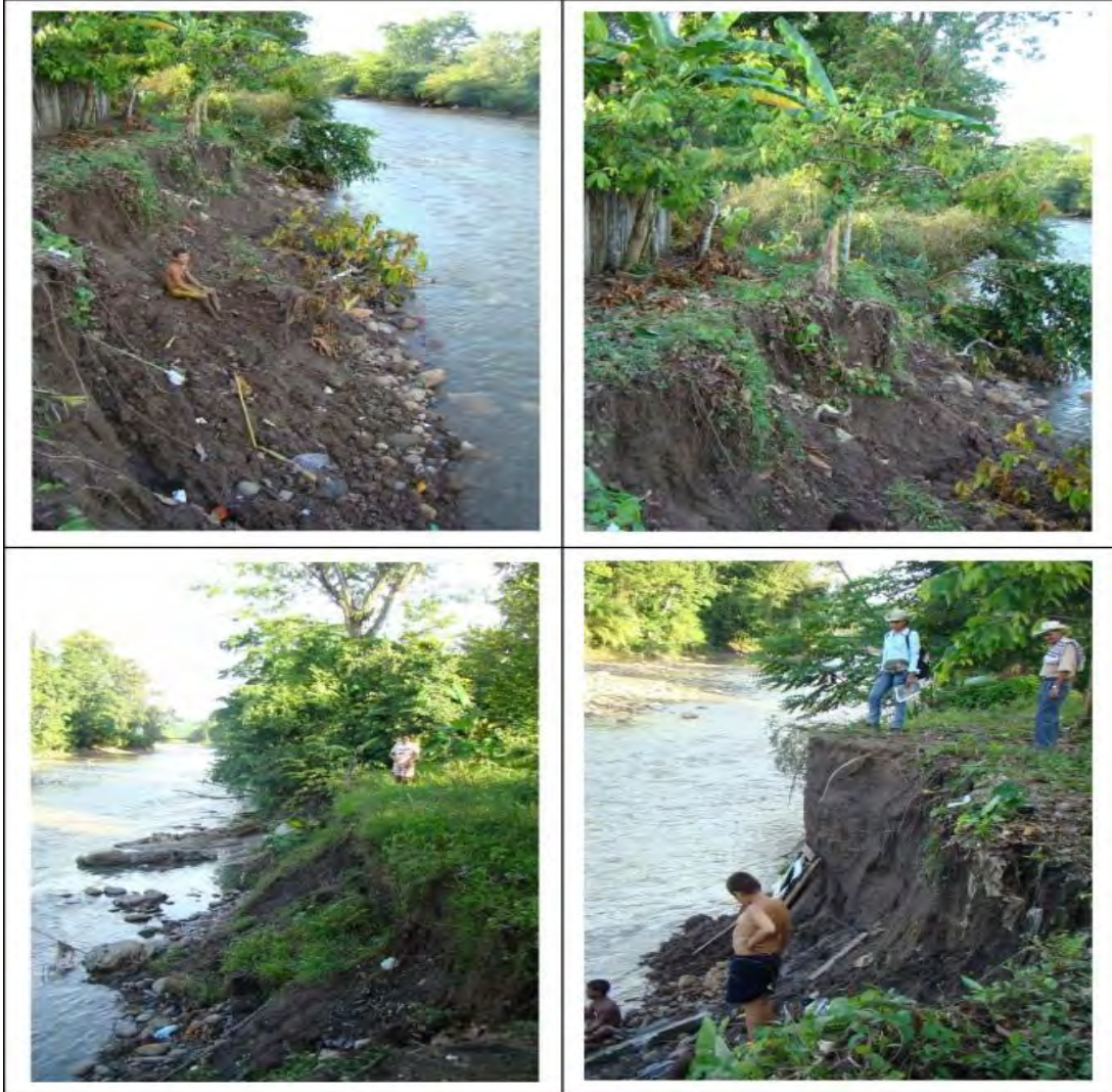
Orillas expuestas en el barrio 28 de abril
