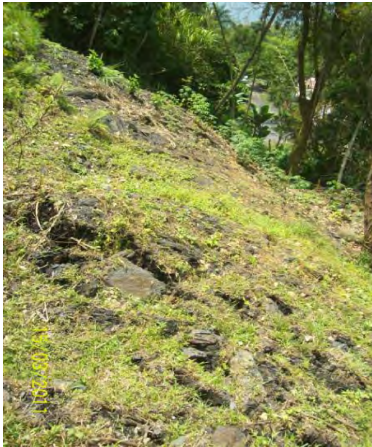
Coluvión al margen oriental de la Quebrada de la Moya.
