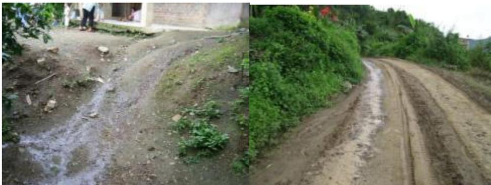
\* Observar el vertimiento de aguas servidas sin ningún manejo y el ausente manejo de aguas de escorrentía en las vías interveredales. Vereda Guambanga
