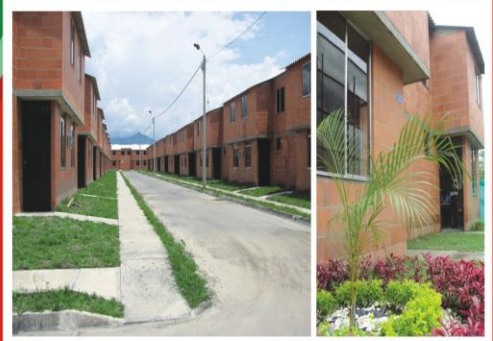
Urbanización La Paz, un proyecto que hace justicia social transformando la realidad del Nor-occidente de nuestro municipio. Vivienda digna con calidad para nuestra comunidad.
