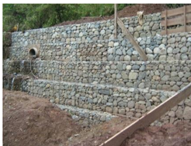
CONSTRUCCIÓN OBRAS DE ARTE EN DIFERENTES VÍAS RURALES
