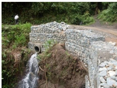
OBRAS DE PROTECCIÓN VÍA LA MANSIÓN - MONTELORO
