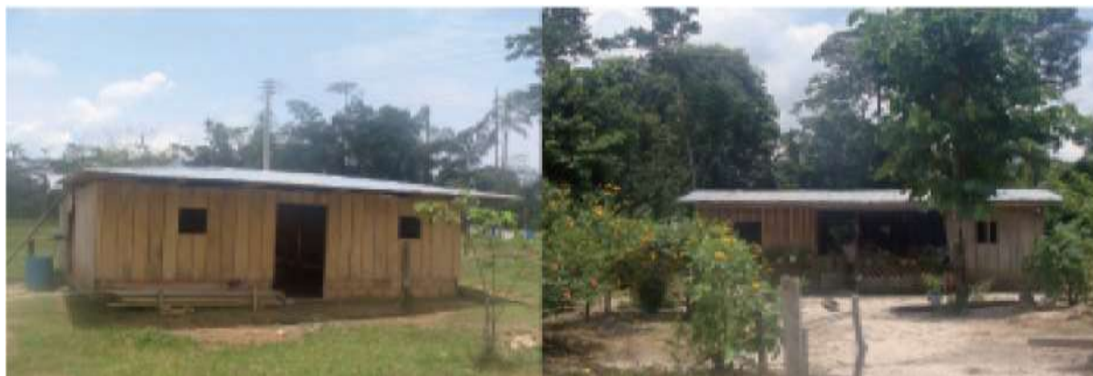
Foto 20 Viviendas área rural – Piamonte
