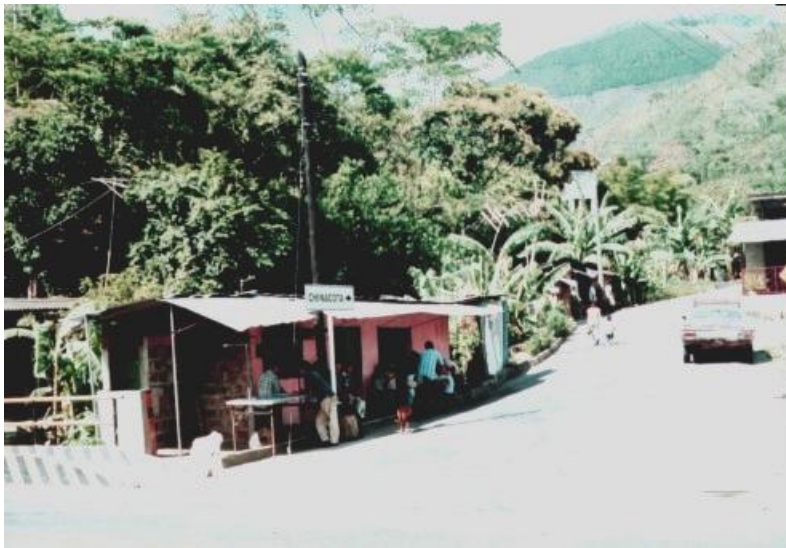
Foto: Vía de acceso al Casco Urbano del Municipio de Chinácota.
