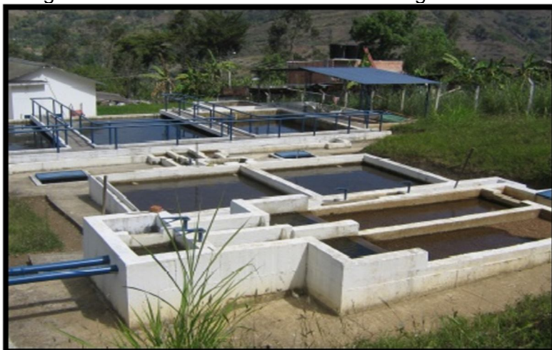
Fotografía 14. Panorámica de la Planta de Agua Potable – Acueducto Urbano
