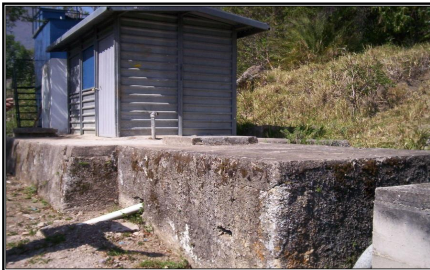
Foto 4. Tanque de Almacenamiento N°1
