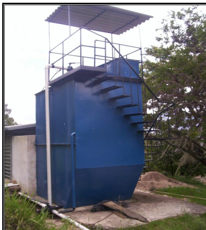
Foto 3. Planta de Tratamiento de Agua Potable
