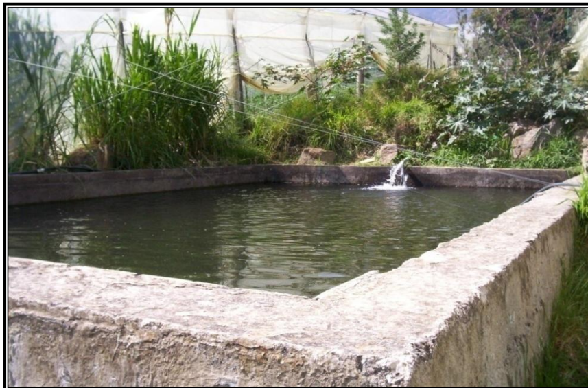
Foto 1. Tanque de Sedimentación
