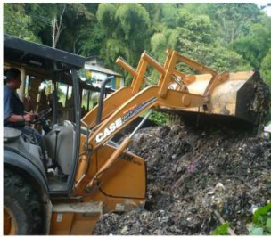
Recuperación y limpieza antiguo basurero
