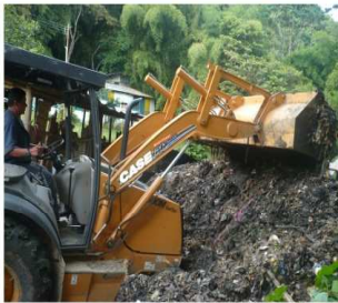
Recuperación y limpieza antiguo basurero
