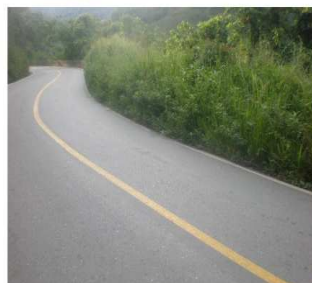
Vía Génova - Barragán
