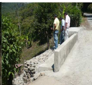
Gaviones vereda El Recreo
