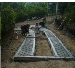
Construcción de huellas
