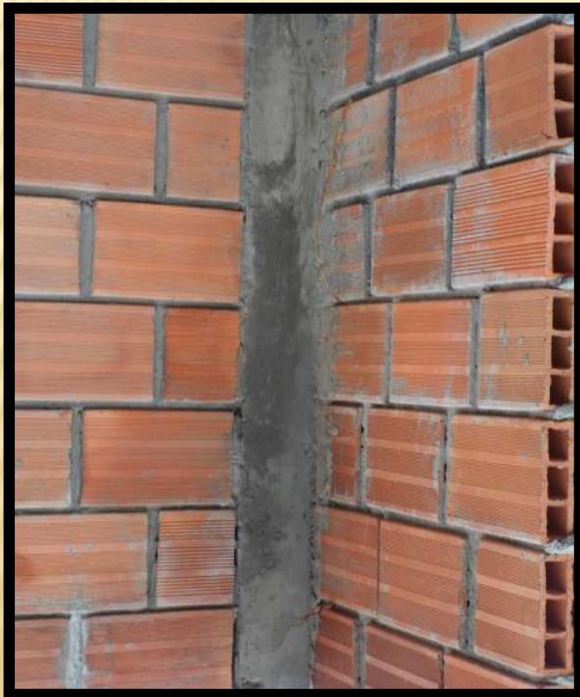
Columna Vaciada
