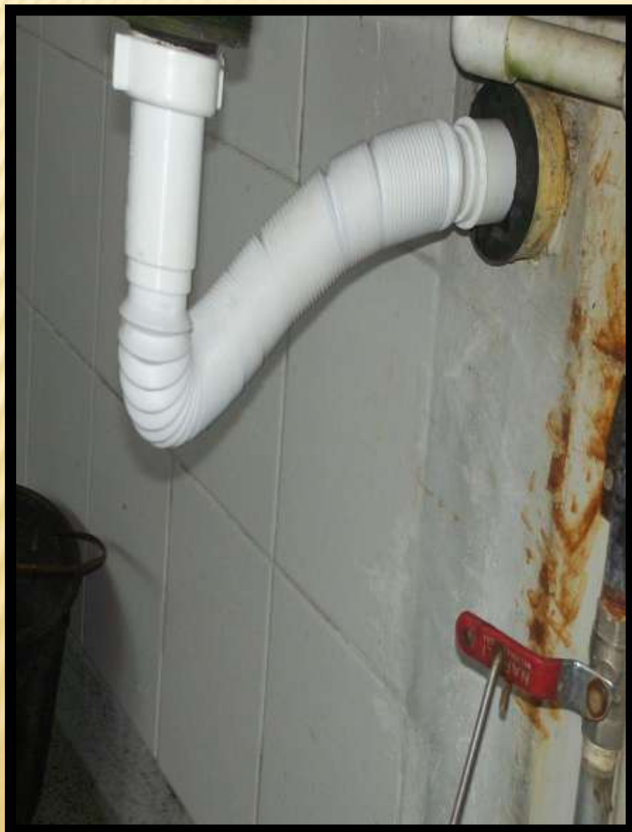
Reparación Lavamanos de Pedal
