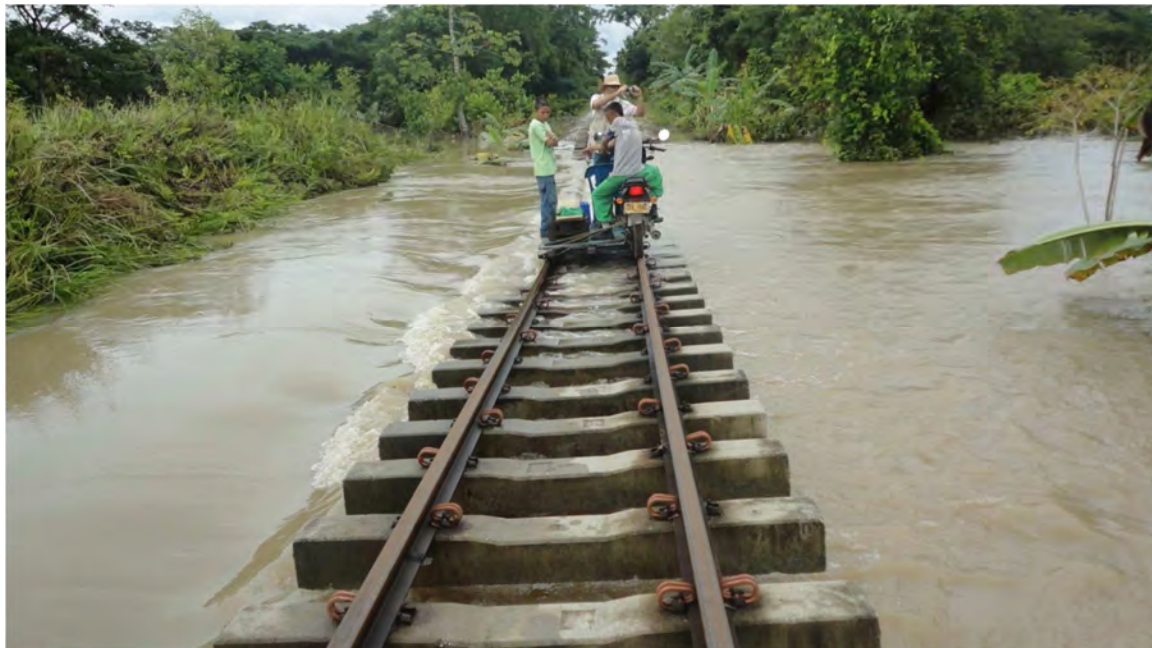
Terraplén de la línea férrea Puerto Berrío - Bogotá
