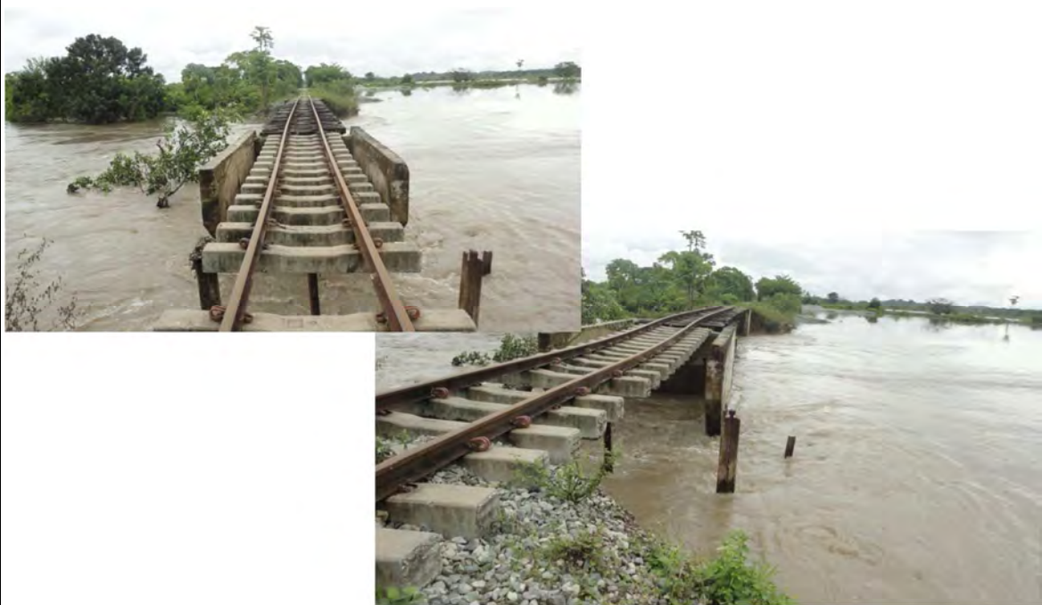
Puente del caño que conecta la ciénaga trapo con el Río
