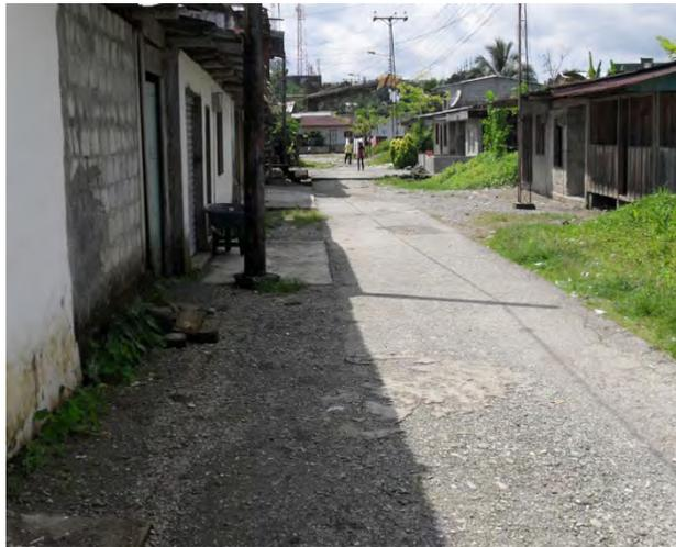
(Madera y concreto) la influencia de la cultura de otras regiones del país, especialmente de Buenaventura, Cali, Popayán, ha contribuido a que se generalice este tipo de edificaciones, que consiste el primer piso en concreto con sus columnas y vigas, el segundo incluyendo el entre piso de madera, con vigas auxiliares en el mismo material, las divisiones en madera, la cubierta en madera y el techo en Zinc, tejalit, o eternit.
