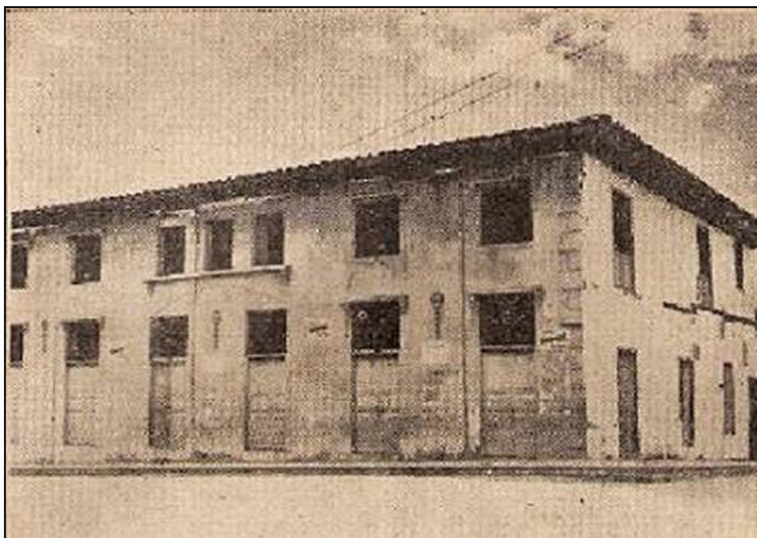
Foto 1. Antigua Casa Consistorial, estaba ubicada en la esquina noreste del parque principal.
