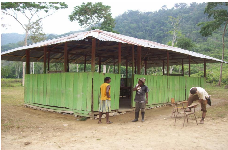
FOTO: 9. Vista del Aula vereda Rangelito
