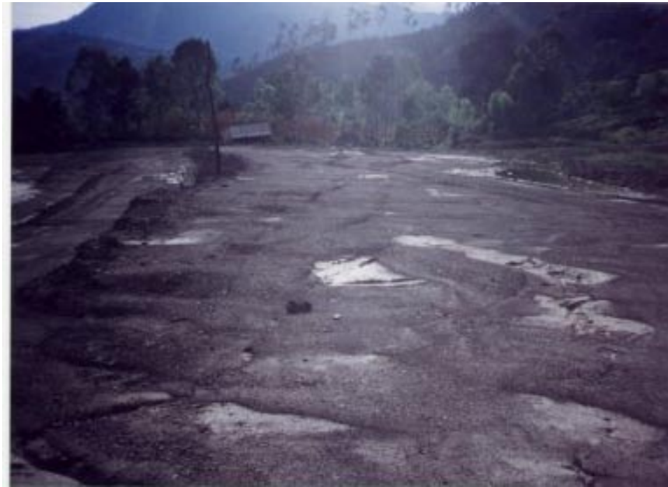
Figura 39. Zona de cancha de fútbol (sector norte de la cabecera)
