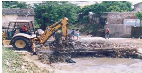
Box culvert de la calle 26, construido en su tiempo sin ningún proyecto integral de la canalización de los arroyos, mostrando la inadecuada disposición de residuos sólidos y la poca capacidad hidráulica para la magnitud del arroyo.
