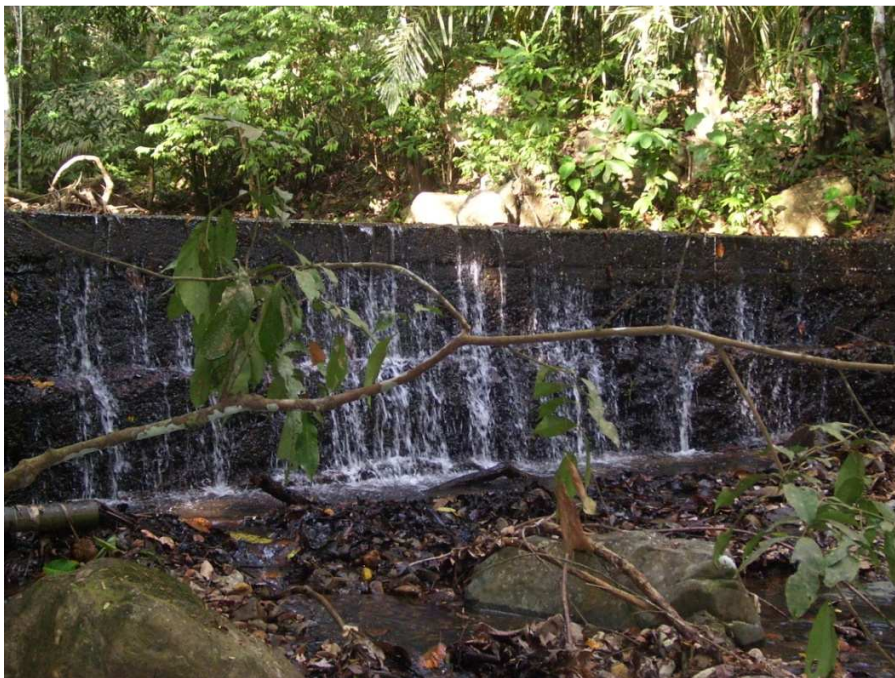
Bocatoma Acueducto Cabecera Municipal
