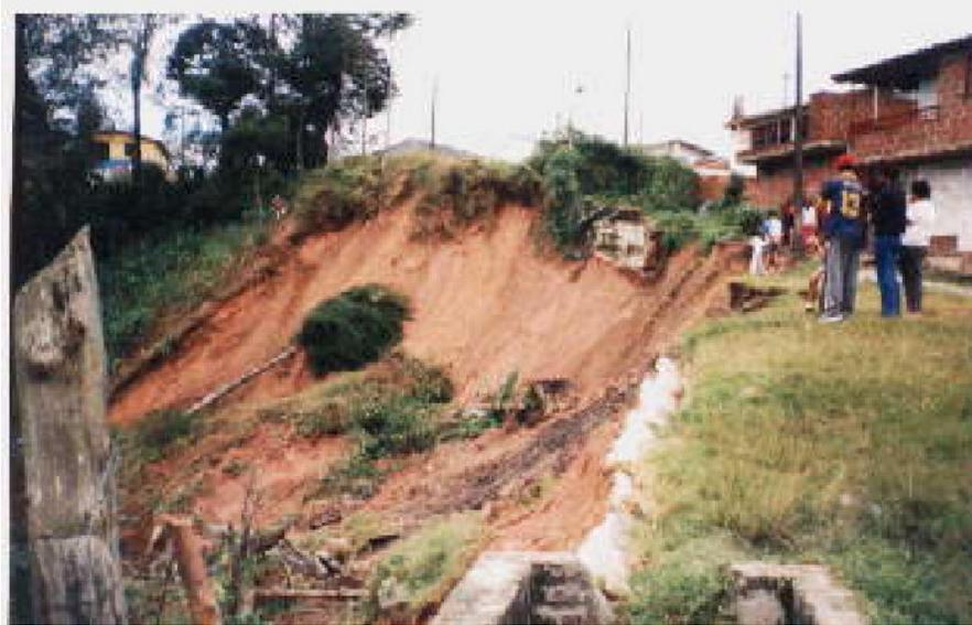
Sector de la Colchonería Vieja, zona de Alto Riesgo por uso inadecuado del terreno: descarga de desechos sólidos, aguas residuales, cultivos inadecuados –plátano- y viviendas con deficiencias constructivas. Nótese la presencia de trinchos enmadera tratando de contener el talud inestable, presencia de ranchos en diversos materiales.
