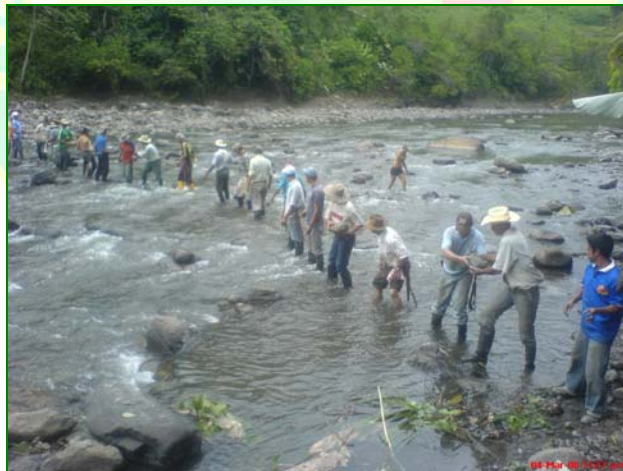
Foto: Trabajos comunitarios en arreglo de la vía Santa Rita
