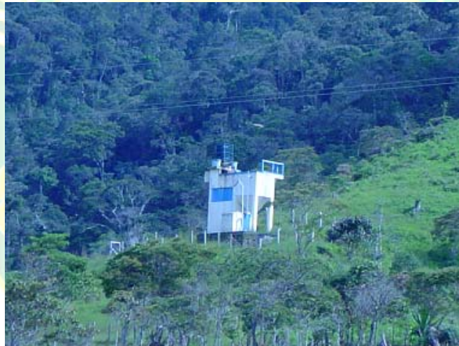
Foto: Planta de tratamiento de agua potable. Cabecera Municipal
