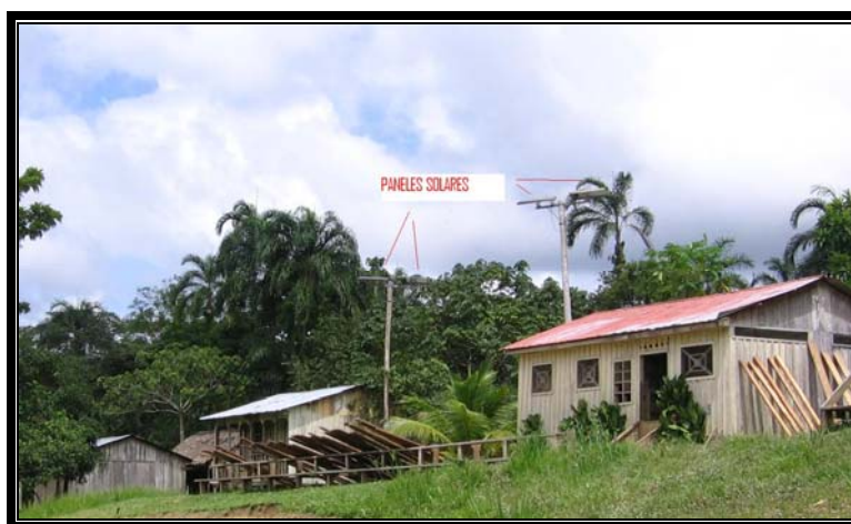
Figura 75 Vista de paneles solares presentes en la comunidad.
