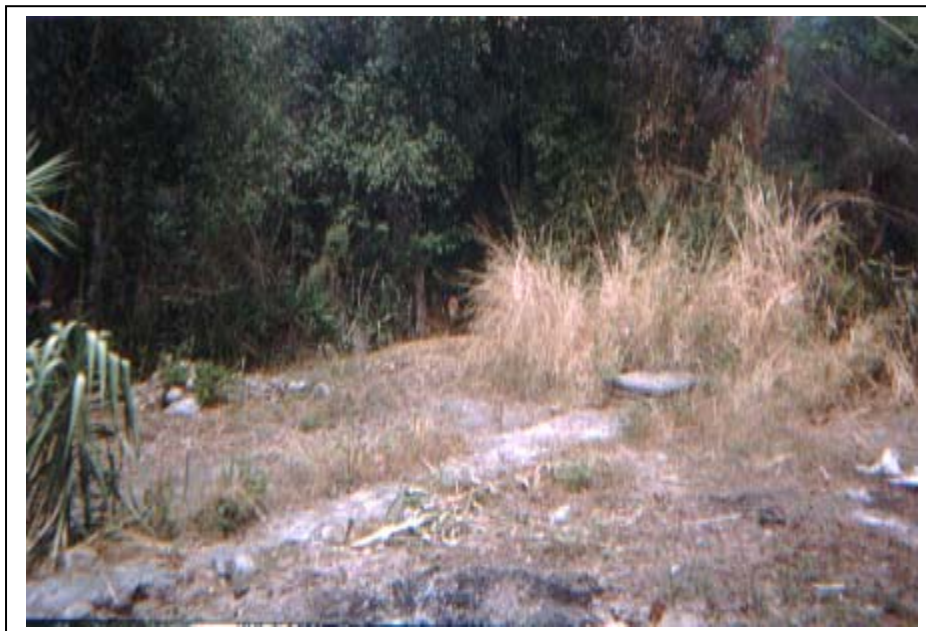
Foto No 16: Alcantarillado Barrio Santa Sofía, afectación en varios predios.
