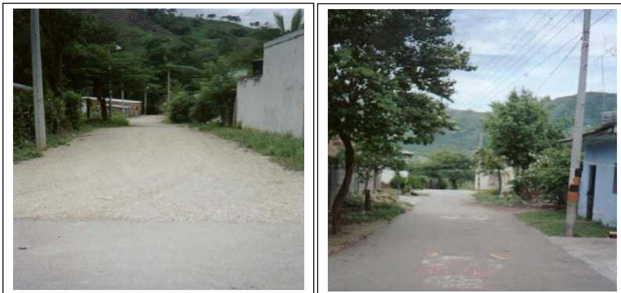
Foto No 11 Vista del interior del Barrio Gaitán
