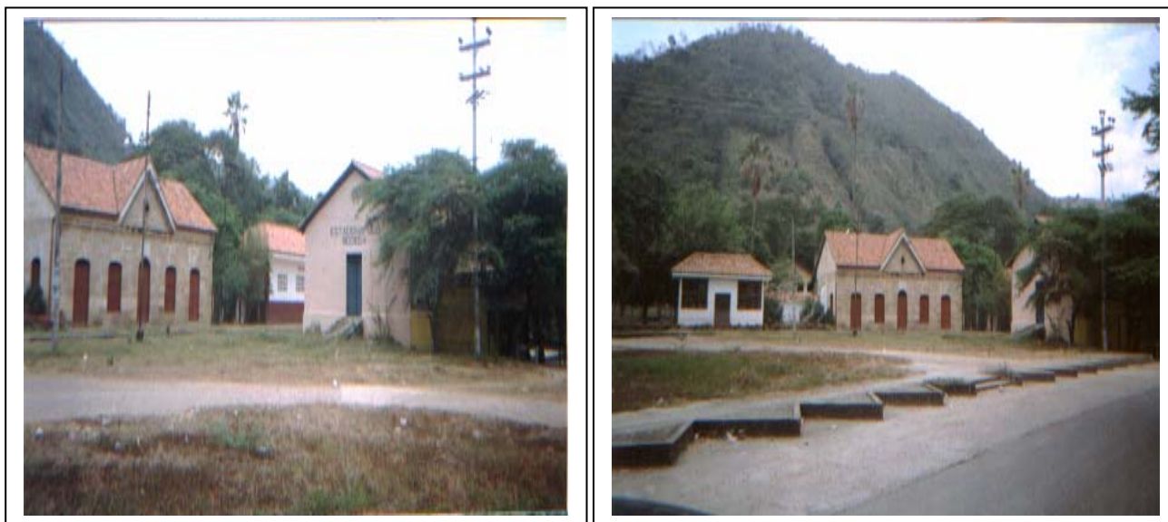
Foto No 31: Areas de Patrimonio Arquitectónico e histórico – lotes de los Ferrocarriles. Actualmente de Propiedad de Particulares.
