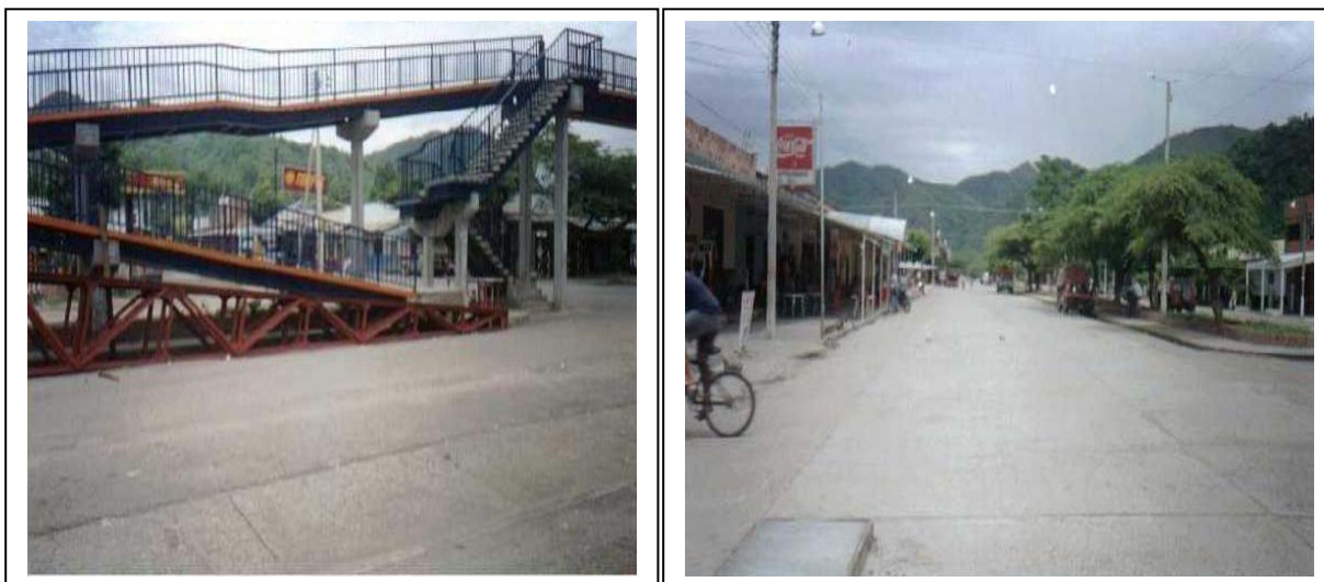
Foto No 4 Vista del Puente Peatonal, y de la Avenida Colombia
