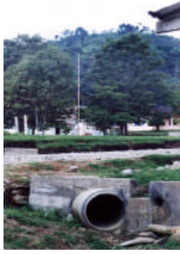
Fotografía - Construcción red de Alcantarillado.
