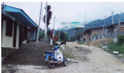
Foto - estado de vía secundaria de Tacueyó.
