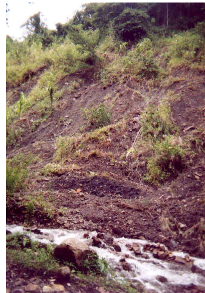
Figura 2.1 Afloramiento de las lutitas de Macanal en la Quebrada Alcaparrosa
