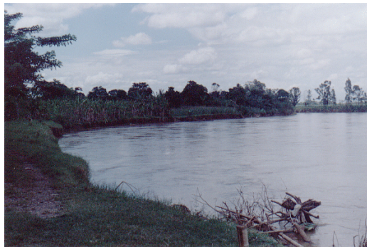
Foto 7 Corregimiento de Quinamayó, sector El Burrito. Erosión marginal causada por el río Cauca.
