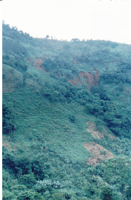
Foto 4 Fenómenos de erosión en el corregimiento de Ampudia
