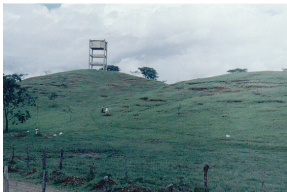
Foto 5 Corregimiento de Robles, tanque de acueducto, erosión por reptación típico de la zona y pata de vaca causada por la ganadería extensiva
