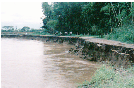
Foto 6 Sector de Playa Amarilla en el corregimiento de Quinamayó. La erosión marginal causada por el río Cauca ha desaparecido la vía
