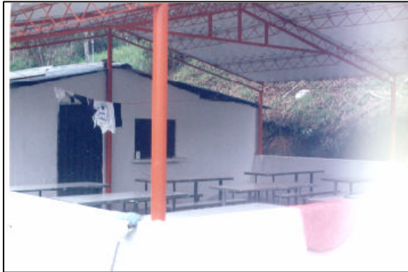
Foto 9 y 10. Estructura metálica para cubierta y Remodelación restaurante escolar Vereda Bremen.
