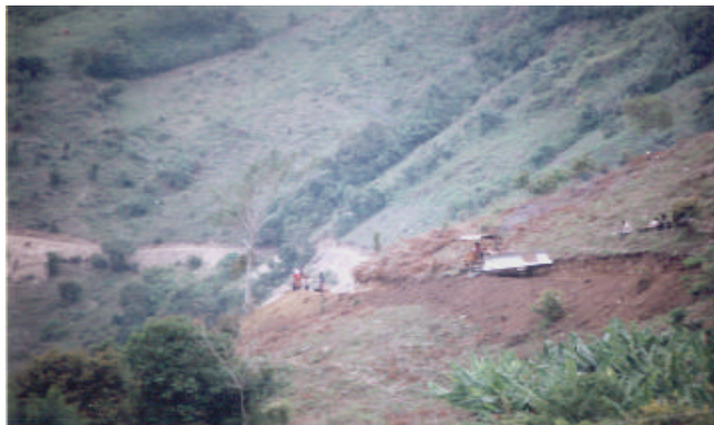
Foto 1. trabajos de apertura y mantenimiento de vías Municipio De Matanza.
