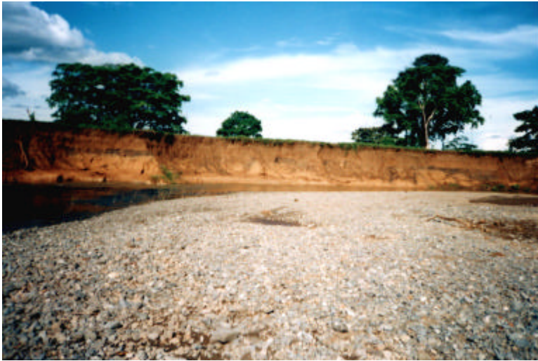
Erosión de Orillas
