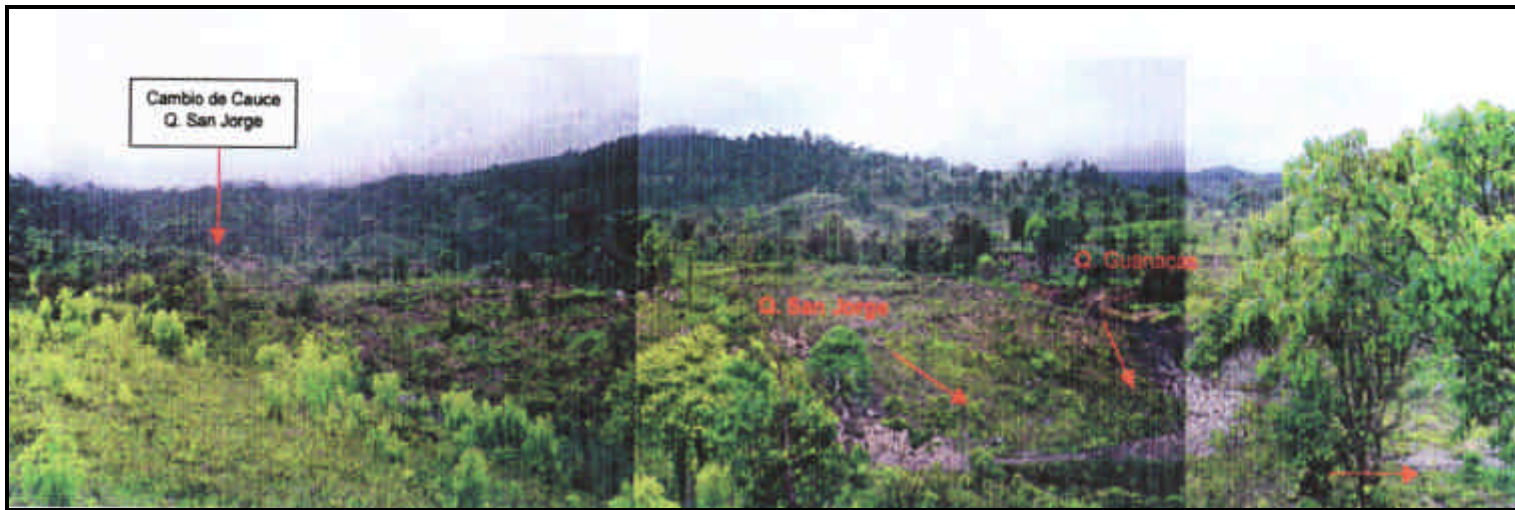
Figura 8 . Procesos de remoción en masa (amenaza alta), vereda Guanacas municipio de Villarrica - Tolima
