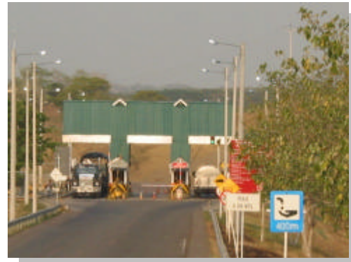
Foto 46. Peaje sobre el puente sobre el Río Magdalena
