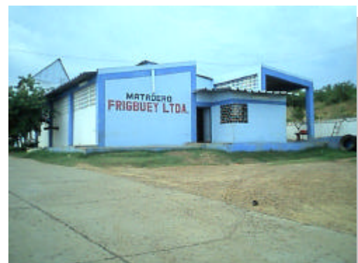
Foto 42. Instalaciones del Matadero Regional
