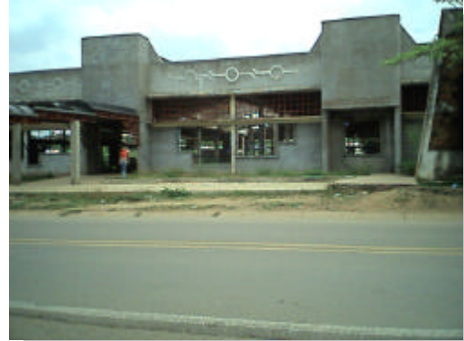
Foto 44. Terminal de Transportes Intermunicipal en construcción.
