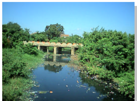
Foto 30. Arroyo Camargo que atraviesa de norte a sur la zona urbana en la parte occidental.
