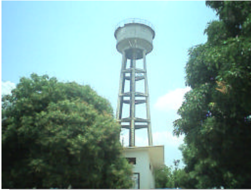
Foto 13. Tanque alto del Sistema de Acueducto localizado en el barrio Policarpa
