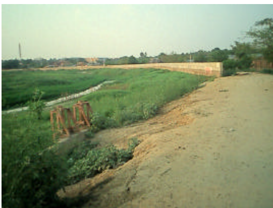
Foto 29. Muro de protección en concreto armado sobre el caño Plato.
