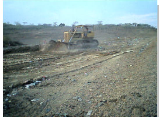
Foto 20. Bulldózer explanando en el relleno sanitario.
