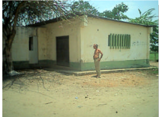
Foto 22. Caseta de bombeo de aguas negras en el barrio Policarpa.
