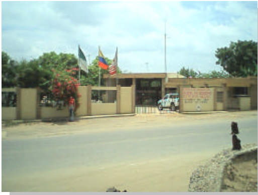
Foto 39. Instalaciones de la estación del Cuerpo de Bomberos
