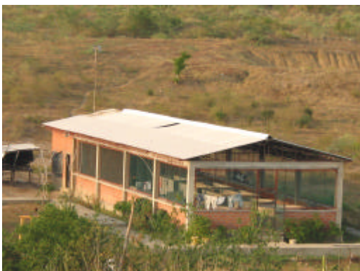
Foto 41. Estación Piscícola en construcción localizada en la cercanía del puente Plato - Zambrano
