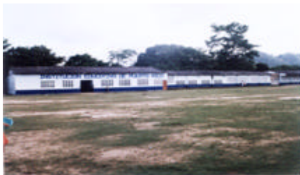
Foto No 11 Vista Institución Educativa de Puerto Rico (Cabecera Municipal)
