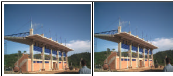
Foto 13. Vista del Polideportivo construido recientemente en la cabecera municipal
