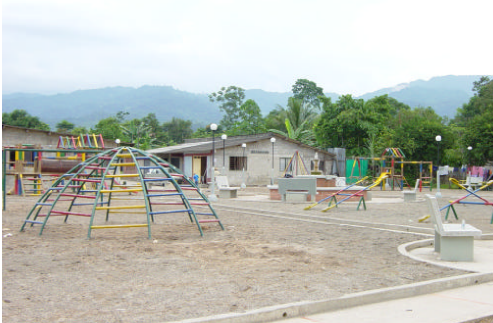
PARQUE INFANTIL (OBRA CONSTRUIDA 2003)
