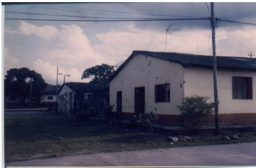
FOTO INFRAESTRUCTURA DE LA ALCALDÍA MUNICIPAL ANTIGUA ESCUELA URBANA
