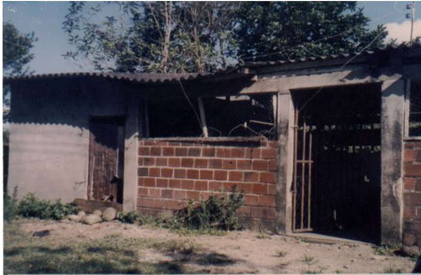
FOTO FACHADA MATADERO MUNICIPAL
