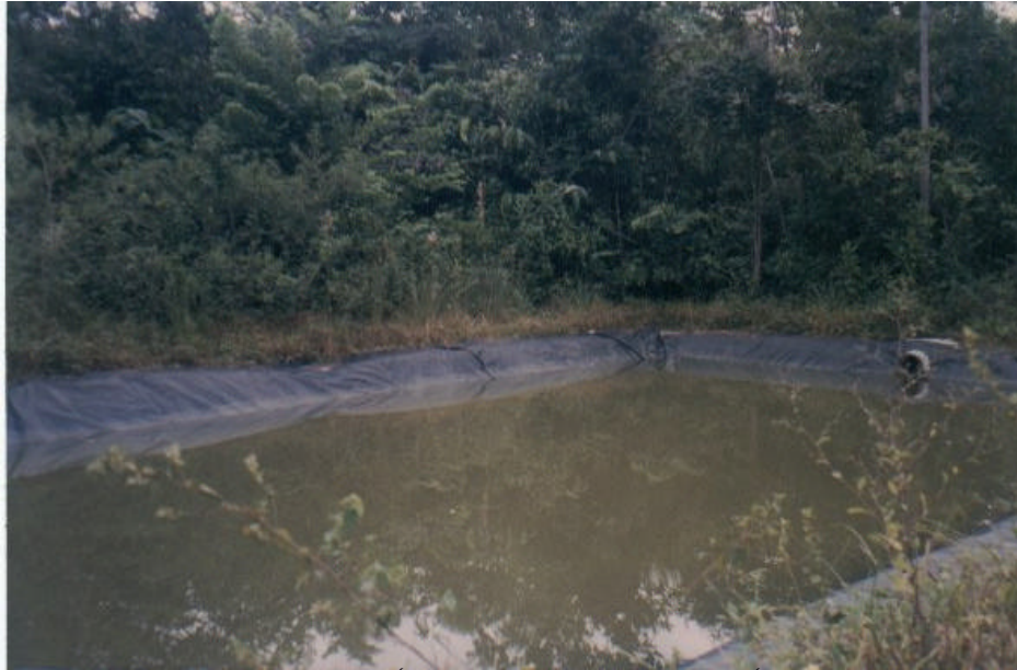
FOTO: LAGUNA DE OXIDACIÓN DEL ALCANTARILLADO DEL CASERIO EL GUAMO
