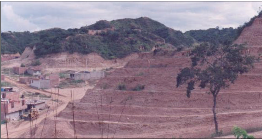
Fotografía 12. Remoción de materiales pétreos para adecuaciones de terrenos. Terraplén para construcción de vivienda sobre el valle del río de Oro (CER, UIS, 1999).
