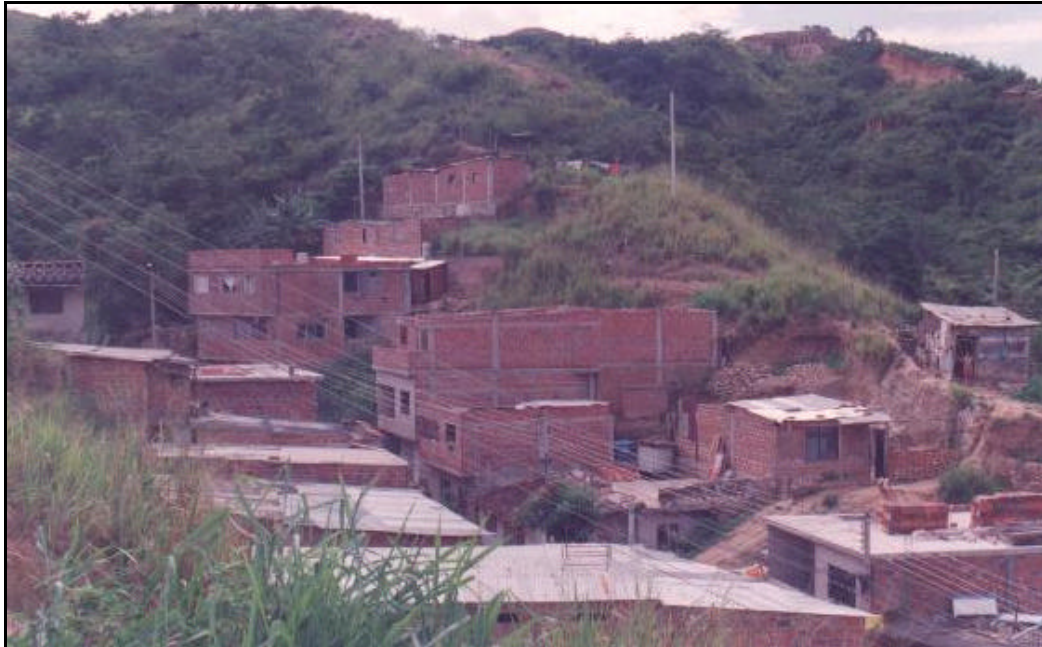
Fotografía 17. Zona de amenaza alta por erosión y deslizamientos. Sector Mesetas (CER, UIS, 1999).
