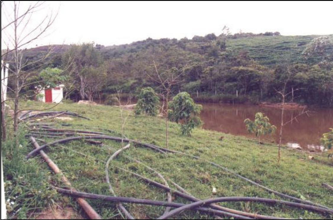
Fotografía 10. Bocatoma acueducto veredal mesa de Ruitoque, sector Acapulco. Las fuentes hídricas de suministro son contaminadas por agroquímicos y residuos de la industria pecuaria (CER, UIS, 1999).
