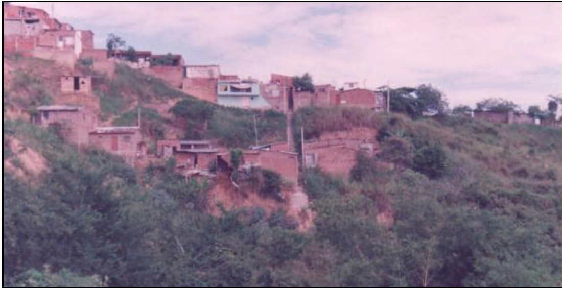
Fotografía 16. Zona de inestabilidad geológica. Construcción de viviendas en zonas de laderas altamente sensibles a la erosión y a los procesos de remoción en masa, en el barrio El Llanito (CER, UIS, 1999).
