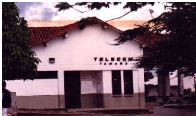
FOTO No 11. INSTALACIONES DE TELECOM – TAMARA
