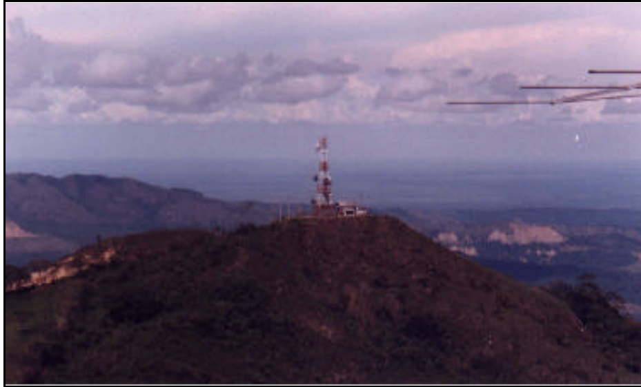
FOTO No 12. ANTENAS DE TELECOM EN EL CERRO SAN ANTONIO
