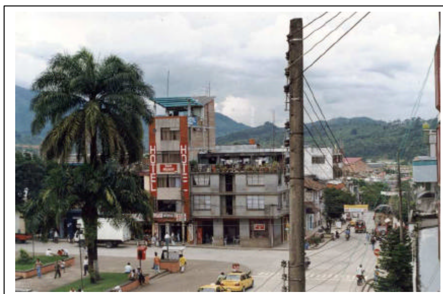
FOTOGRAFIA 5. HOTEL SAN MIGEL SOBREPASA EXAGERADAMENTE LOS NIVELES DE LOS EDIFICIOS VECINOS EN UN FRETE MUY REDUCIDO
