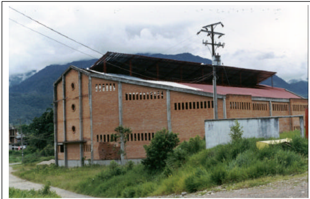
FOTOGRAFIA 20: COLISEO DESPUÉS E CUATRO AÑOS DE CONSTRUIDO NO SE HA HABILITADO PARA SU USO.
