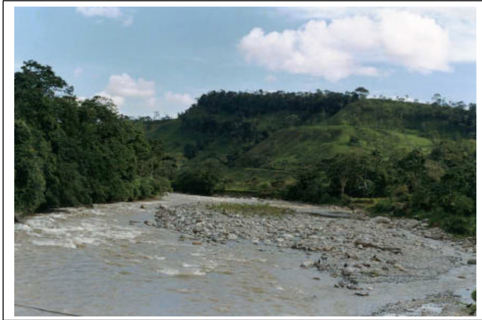
FOTOGRAFIA 39:VEGA DEL RIO MOCOA DESARROLLO DE UNA ALAMEDA SOBRE EL MARGEN OCCIDENTALQUE AYUDARA A MITIGAR EL RIESGO DE UNA INUNDACION
