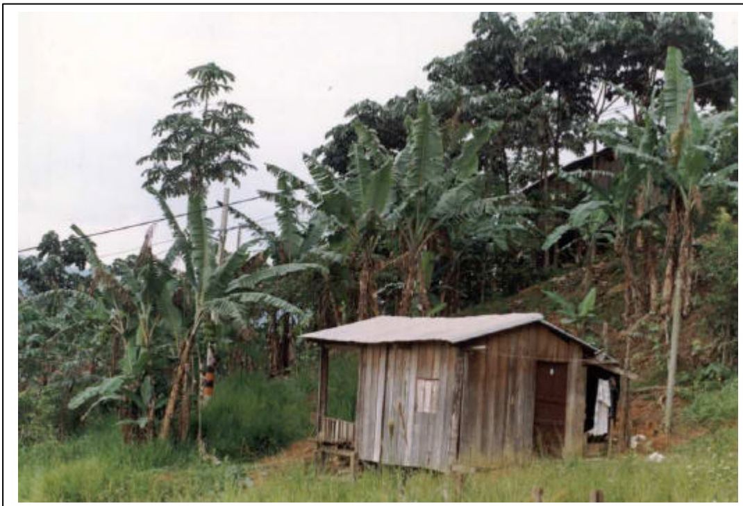
FOTOGRAFIA 22: AUNQUE ES BUENO EN GENERAL EL ESTADO DE LAS VIVIENDAS EN LA CIUDAD SE PRESENTAN ZONAS DONDE ES CRITICO EL DESARROLLO DE ESTA, COMO SE VE EN LA FOTO
